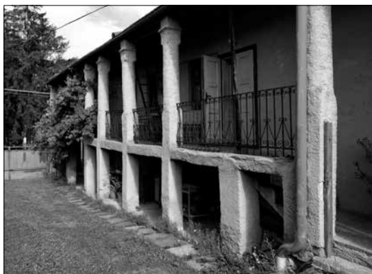
Ábelová č. 112, pohľad z dvora
